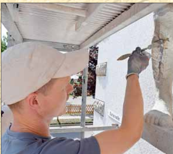
Der Steinmetz Andreas Jönsson wirkt hier quasi als Orthopäde und „heilt“ ein beschädigtes Bein.
